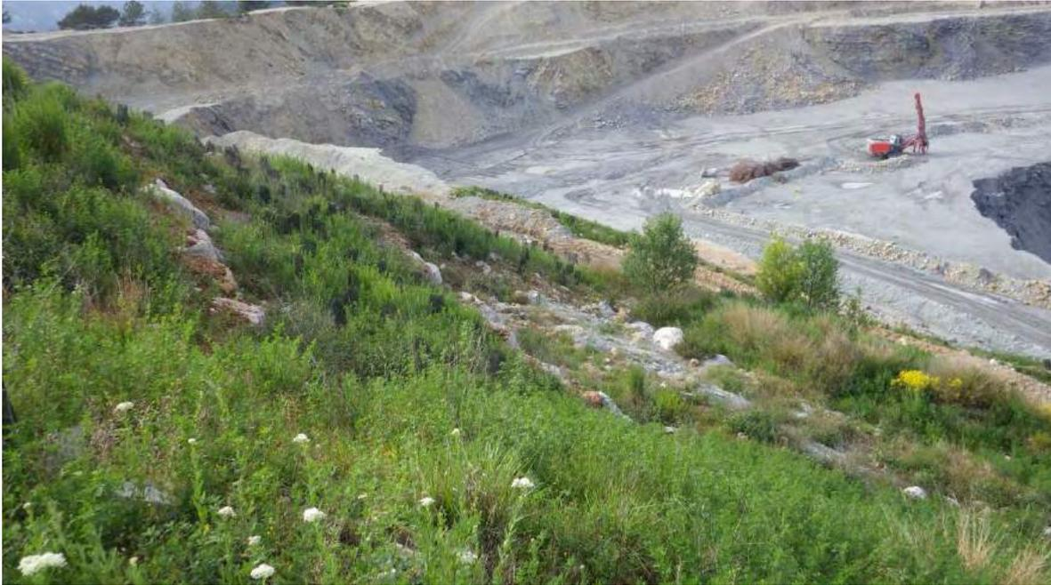
*Glissements superficiels dans les marnes (passage de faille- mylonite). Le confortement actuel est très superficiel (quelques blocs qui descendent avec les marnes instables)*
