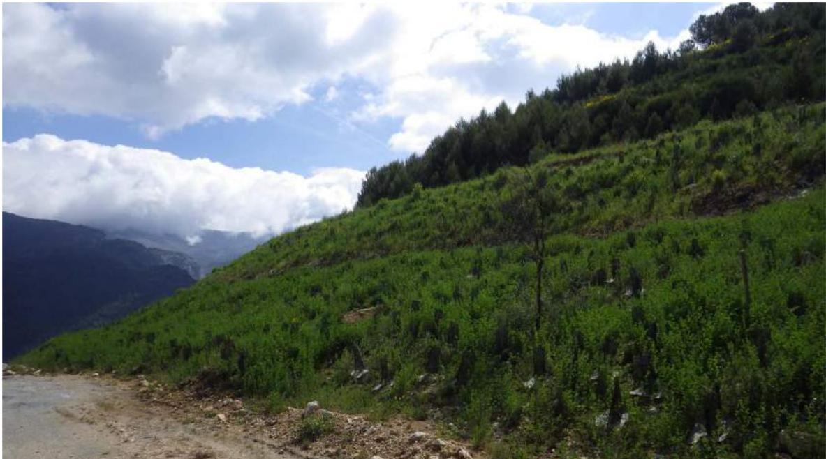
*Le remblai est stable à une pente de 35° lorsque celui-ci est bien drainé. Il permet de plus de conforter (stabiliser) les fronts marneux.*
