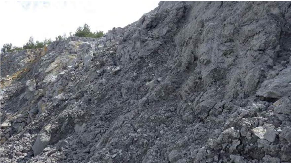
*Front recoupant les plans de failles broyées en direction N120-N140. Le front n'a pas de cohésion. Il se dégrade et glisse avec l'eau. Les glissements superficiels situés dans les gradins 351 à 374 sont situés dans ce type de faciès.*
