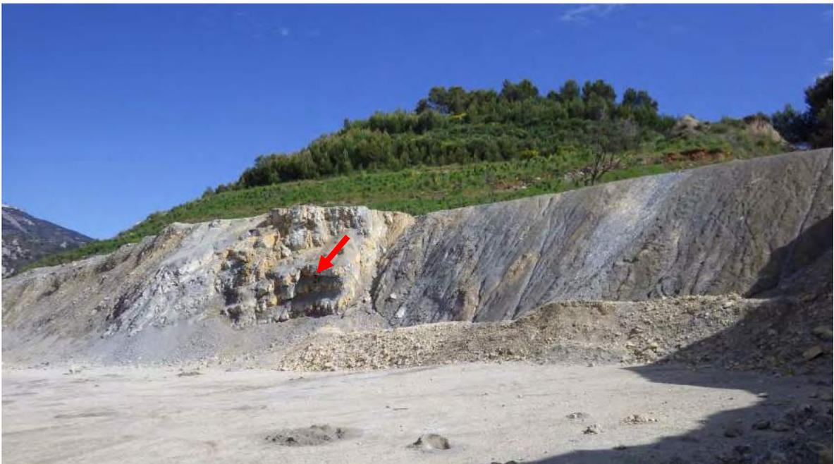
*Découpage des fronts selon les plans de stratification à 35°. En rouge, la stratification est recoupée au pied. La pente de découpage est supérieure au pendage des couches. Le sommet du front va glisser à terme.*
